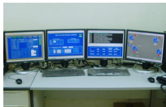
Figure 7 : Les postes de visualisation à distance utilisés dans la centrale de MOH assurent une visibilité et des diagnostics en continu pour tout le système.
