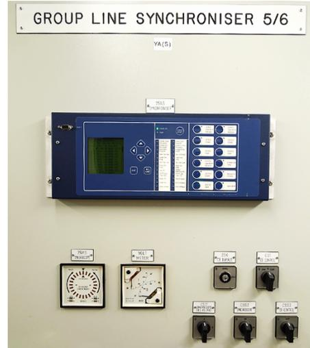
Fig. 7. Example Line-Synchronising Panel
