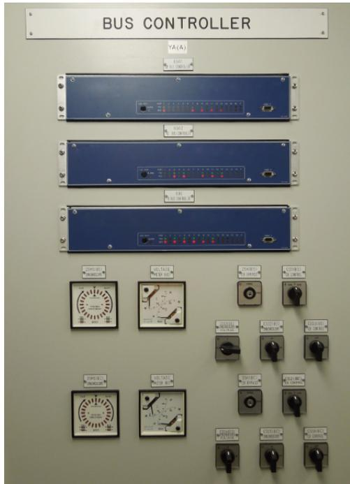
Fig. 6. Example Bus-Synchronising Panel
