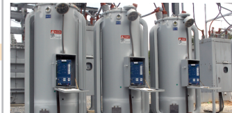
Controle de regulador de tensão (SEL-2431)
