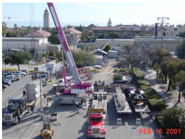
Figura 6 Transformador de 33 MVA Durante a Instalação
