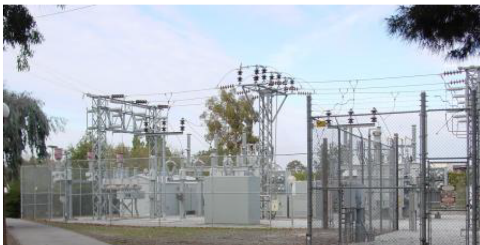
Figura 8 Subestação Palou, Vista do Norte—Modernização Concluída
