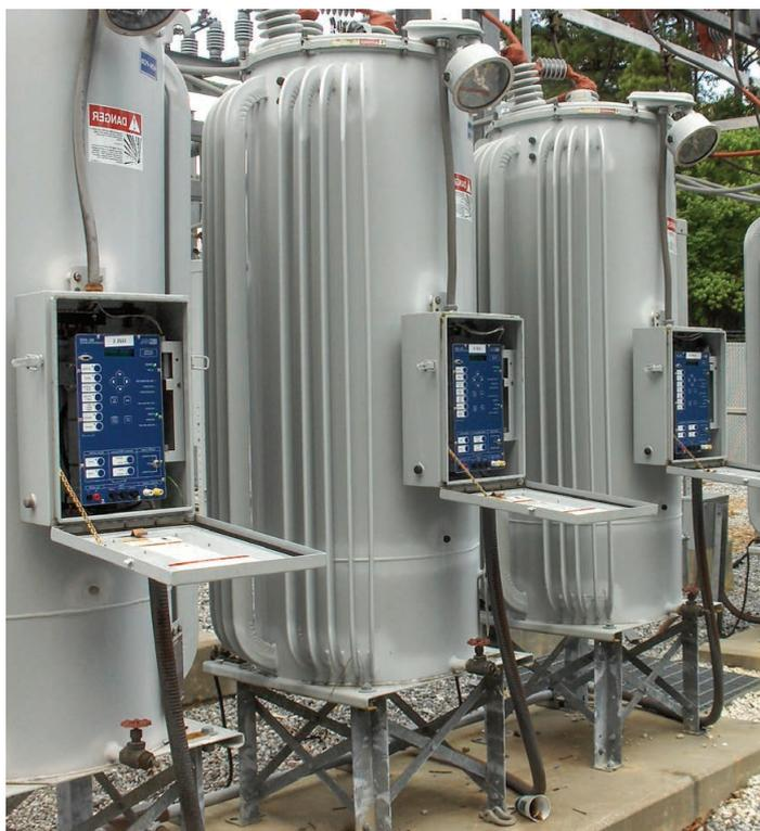
O controlador de reguladores de tensão SEL-2431 é responsável pela manutenção do nível nominal da tensão de operação em redes de distribuição aéreas, garantindo que a energia elétrica chegue dentro dos limites de qualidade aos clientes, evitando a aplicação de multas.
