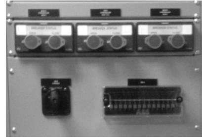
Fig. 9. Módulo de chaves de controle com indicação localizado na casa de controle.
