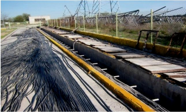
Fig. 3. Condutores de cobre removidos das trincheiras de cabos e substituídos pela tecnologia baseada na troca de mensagens digitais.
