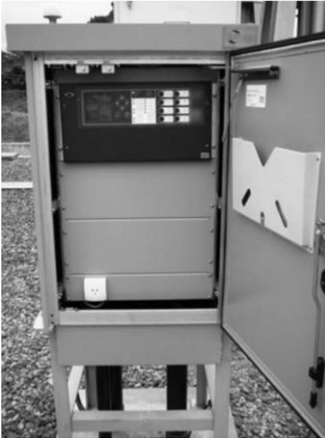
Fig. 10. Instalação típica de um quiosque de campo com IEDs.
