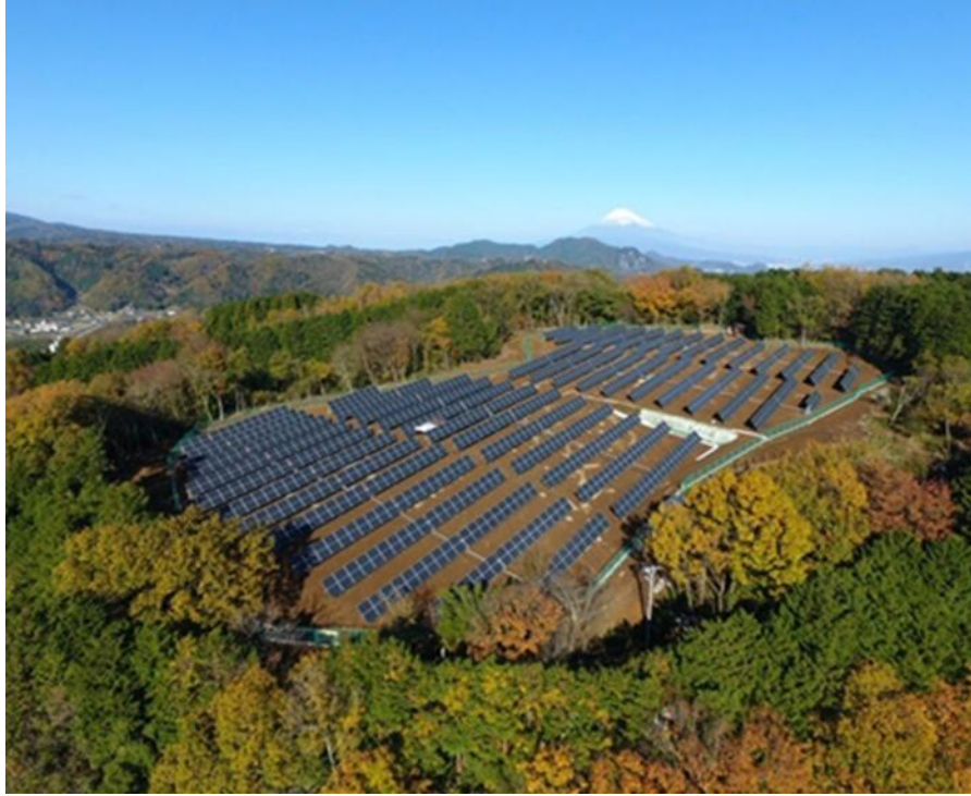
Figura 3 Planta de energía fotovoltaica
