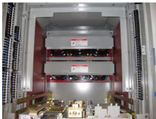
Fig. 3. Guilhotinas fechadas em um cubículo LSC2B-PM e detalhe o Disjuntor.
