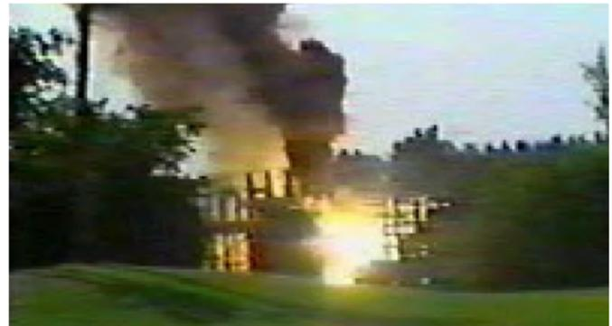
Fig. 1. Perda de um Transformador de Subestação após uma Falha do Sistema CC.
