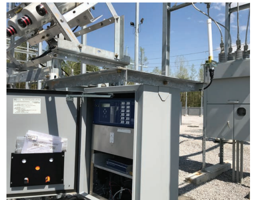
Figura 8 - Antena omnidirecional conectada ao SEL-FR12 para se comunicar com os transmissores SEL-FT50.
