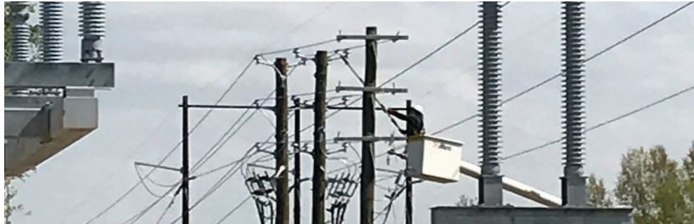
Figura 9 - Um trabalhador de linha instala um SEL-FT50 fora da subestação Northside na seção aérea do alimentador.
