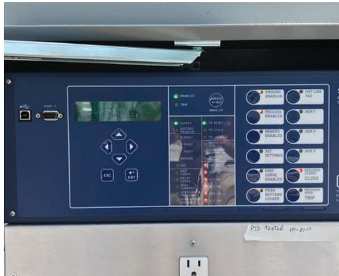
Figura 7 — Un SEL-FR12 instalado en el gabinete del control de restaurador SEL-651R.
