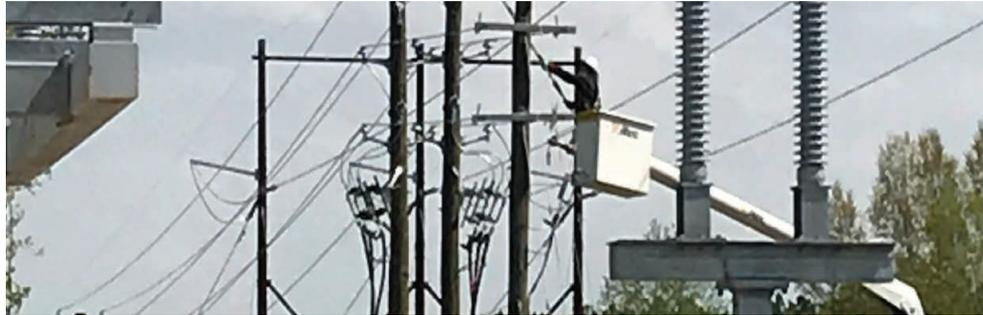
Figura 9 — Un trabajador de línea instala un SEL-FT50 fuera de la subestación Northside en la sección aérea del alimentador.
