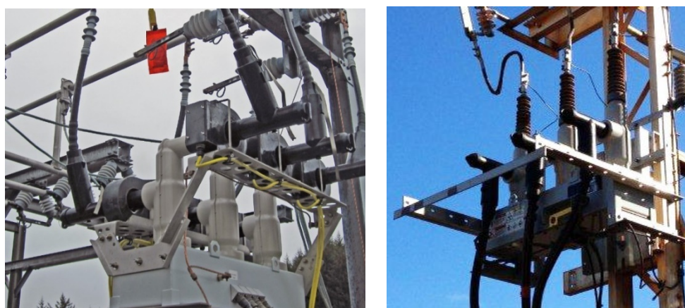
Figura 11 Religadores G&W Viper Conectados Via Elbow
