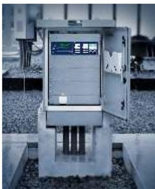
Relé SEL-311C instalado no pátio
