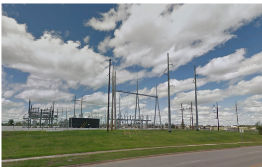
Рисунок 4. Реконструированная подстанция Empire на 26-й улице Джоплина (Google)
