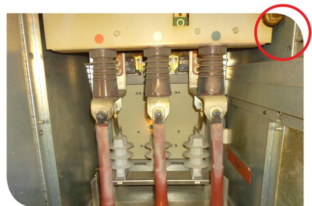
*La cabeza del sensor de arco eléctrico es visible en la parte superior derecha.*
