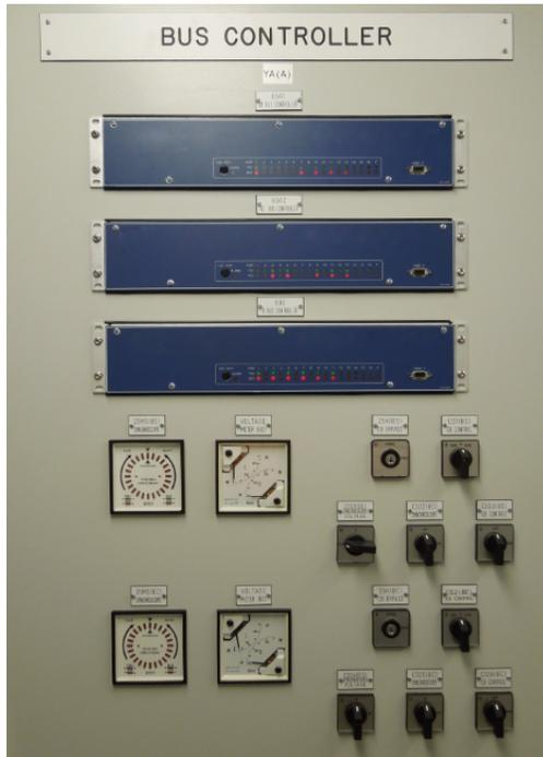
Fig. 6. Example Bus-Synchronising Panel
