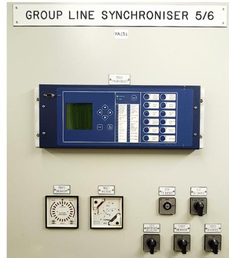
Fig. 7. Example Line-Synchronising Panel
